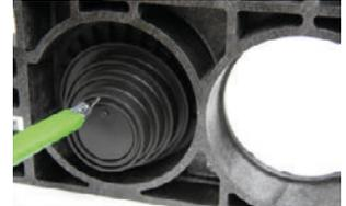
Stufentülle für Öffnung Ø 110 mm
